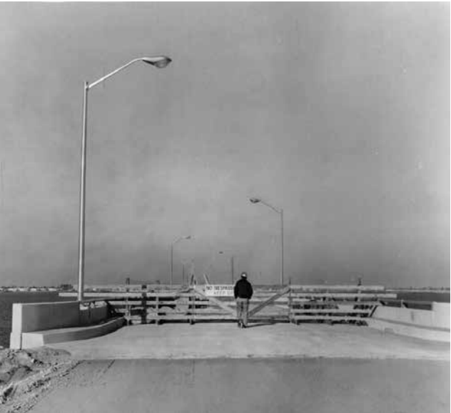
Construcción del Puente de Cape Coral – 1964
