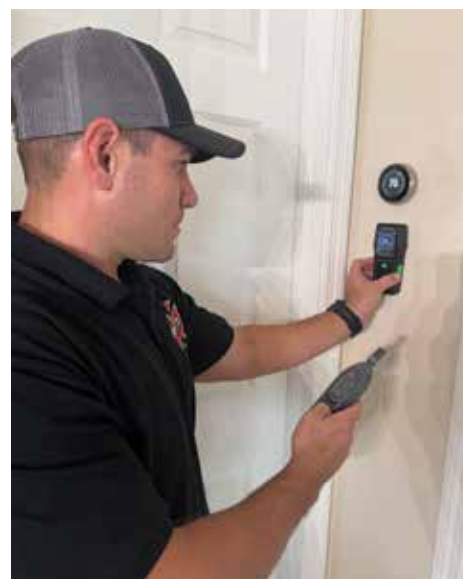
Revisión del funcionamiento correcto del termostato, niveles de humedad y lecturas de humedad ambiental, asegurando que estén dentro de los límites normales y programaciones establecidas.
